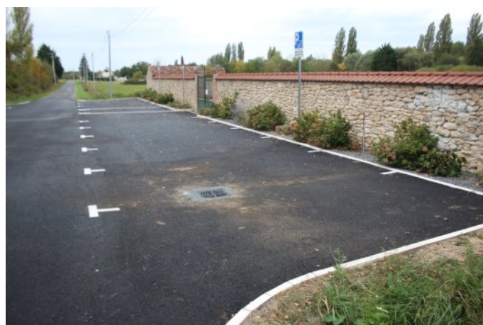
Marquage des places de stationnement et accessibilité
